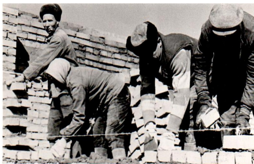
Идёт стройка здания школы
